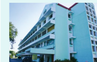
エンジニアリングビル(工学部)
