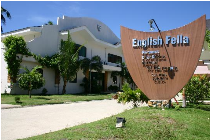
スクールビルディングのうちの1棟
